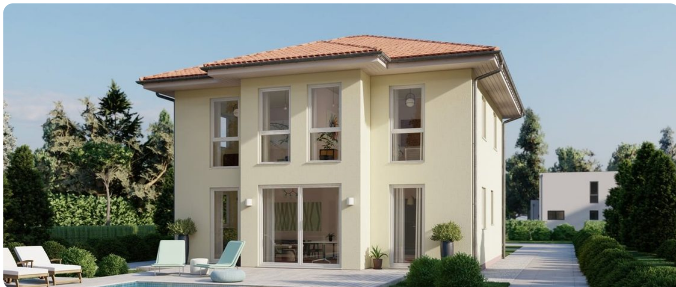
Terrassenseite mit bodentiefen Fenstertüren zum Garten.
