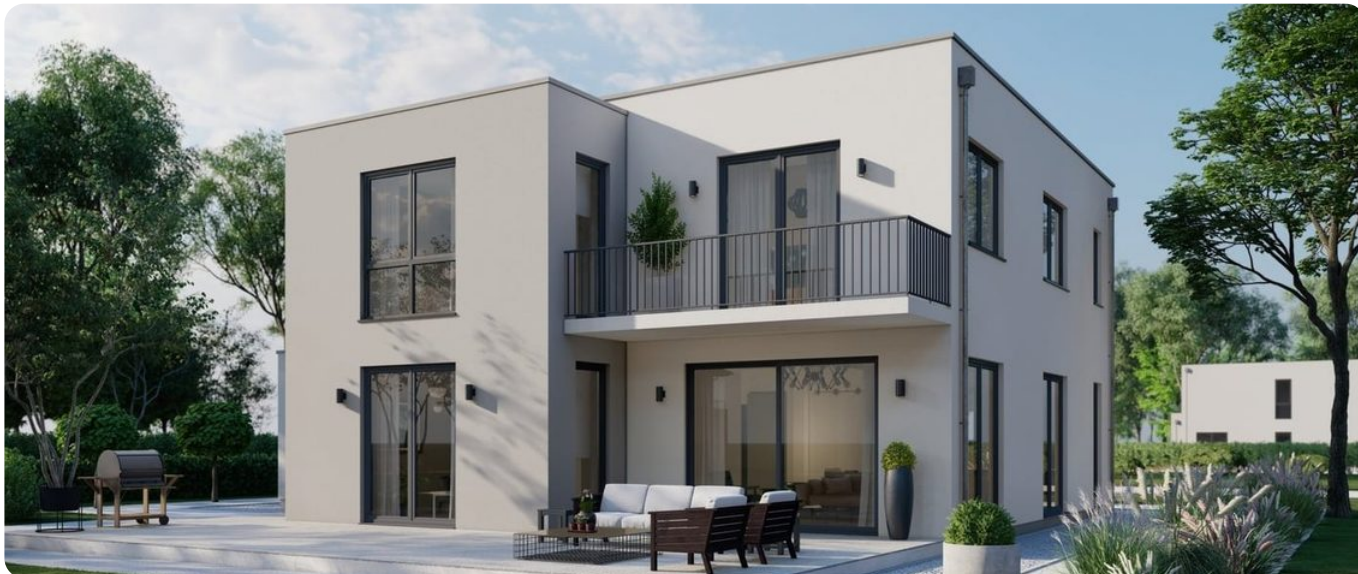
Terrassenseite mit bodentiefen Fenstertüren zum Garten.
